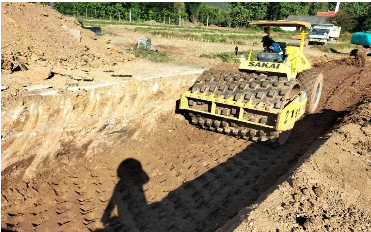
รูปที่ 1.9-15 งานดินถมบดอัดแน่นและทดสอบความหนาแน่น ระบบท่อส่งน้ำฝ่งซ้าย
