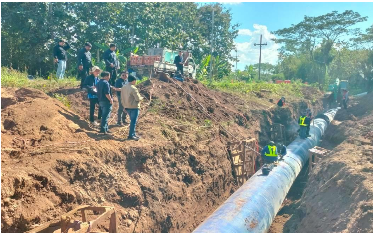
รูปที่ 1.9-13 งานวางท่อ เชื่อมรอยต่อ และทดสอบรอยเชื่อม พื้นที่ก่อสร้าง ระบบท่อส่งน้ำฝางซ้าย
