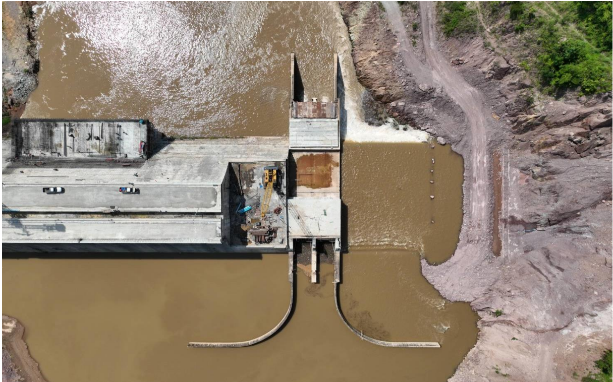
รูปที่ 1.9-3 งานก่อสร้างอาคารทางระบายน้ำล้นและอาคารผันน้ำลงลำน้ำเดิม
