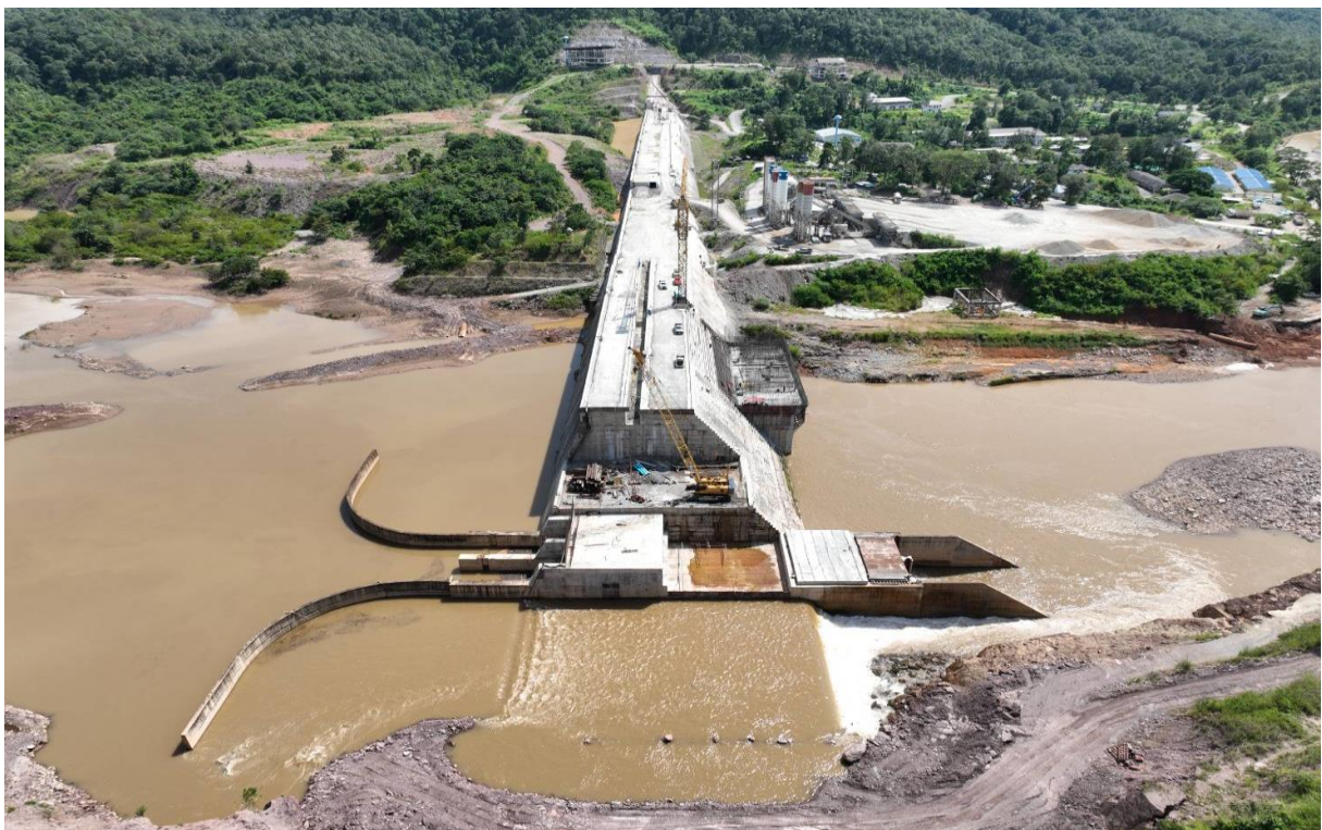
รูปที่ 1.9-2 งานก่อสร้างตัวเขื่อนคอนกรีตบดอัด
