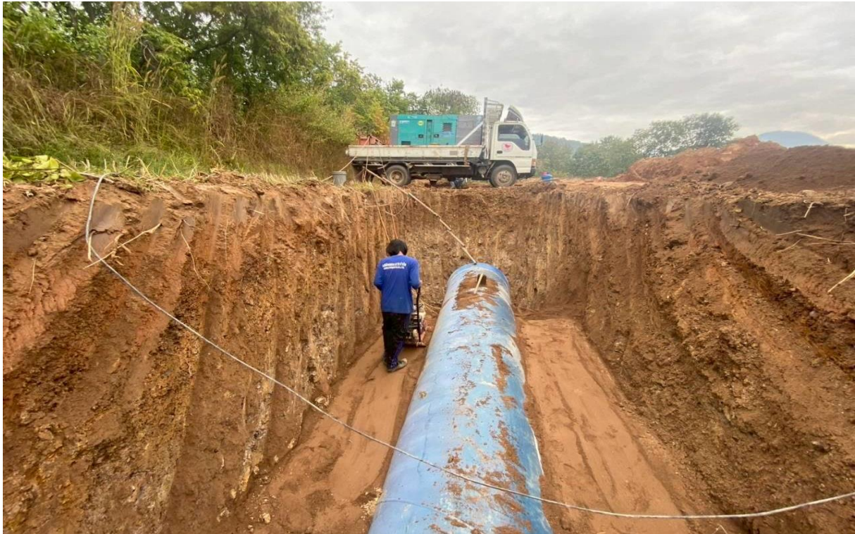
รูปที่ 1.9-12 งานทรายถมบดอัดแน่นและทดสอบความหนาแน่น พื้นที่ก่อสร้าง ระบบท่อส่งน้ำฝางซ้าย
