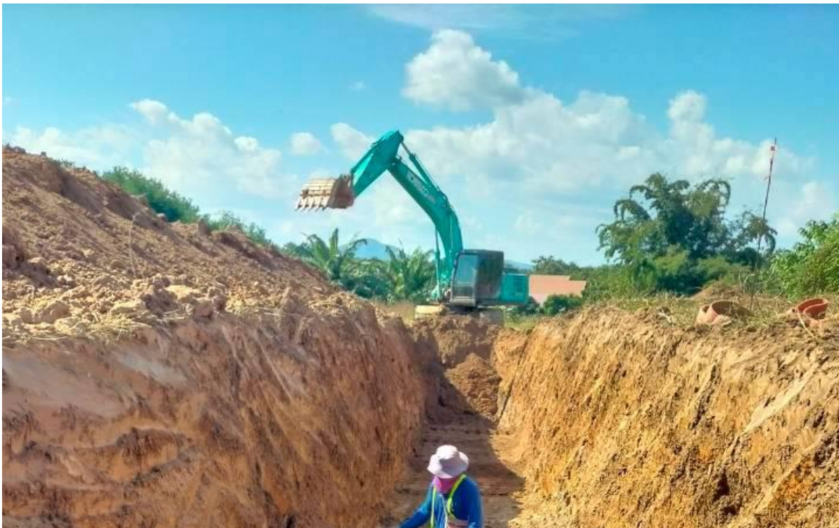
รูปที่ 1.9-11 งานขุดเปิดหน้าดินและขุดดินด้วยเครื่องจักร พื้นที่ก่อสร้าง ระบบท่อส่งน้ำฝ่งซ้าย
